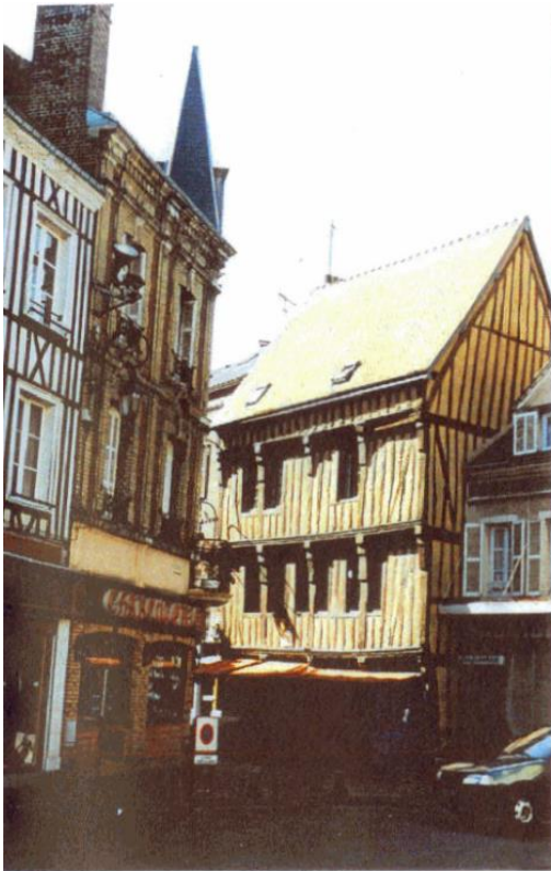
Pan de bois restauré, réalisé à l'origine pour rester apparent
