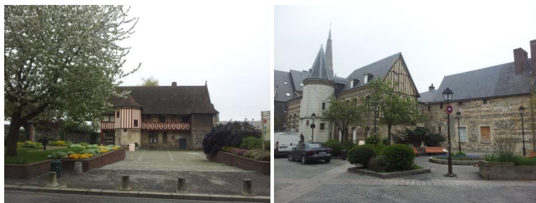
Présence végétale près du prieuré et de la bibliothèque
