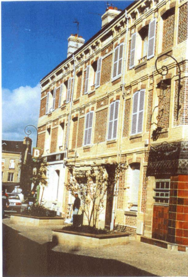
Façades de brique rouge et blanche
