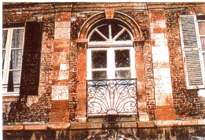
35, rue Thiers - dans la cour, aucun doute sur les parties à enduire.
