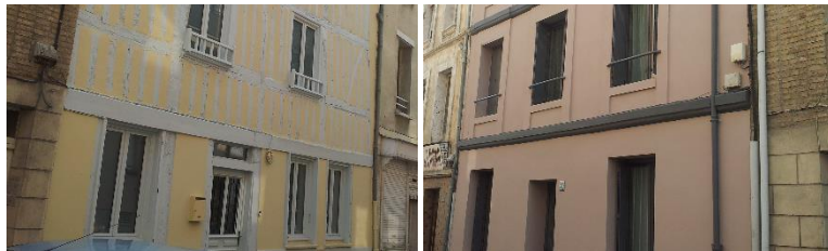
26 rue Saint-Just / 30 rue Saint-Just
