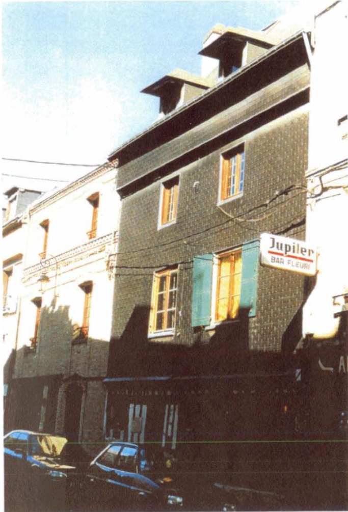
Pan de bois recouvert d'un bardage d'ardoise sur la totalité de la façade
