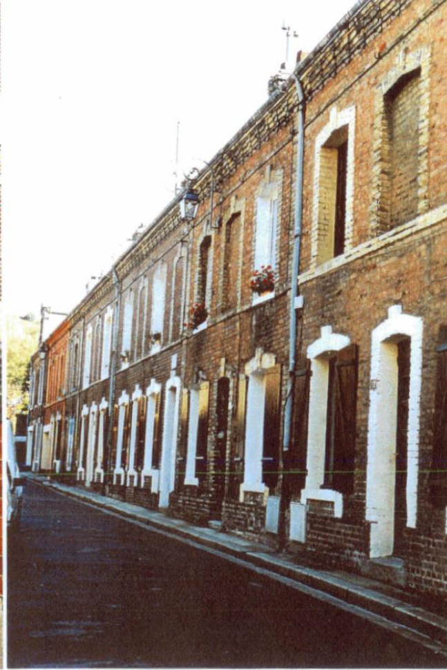
Maisons ouvrières en bande Brique rouge et blanche
