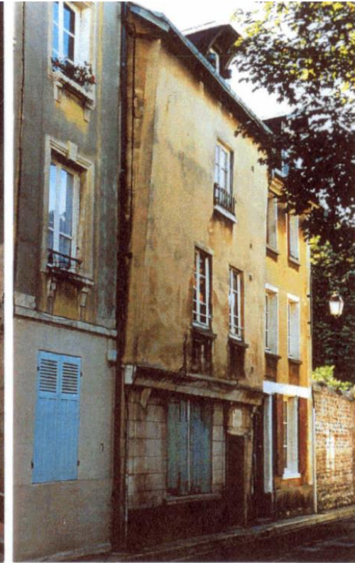
Pan de bois recouvert d'un enduit ciment l'encorbellement : poutre sculptée ?
